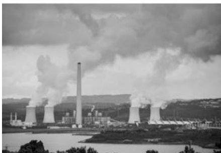
Central tèrmica d'As Pontes (la Corunya)
